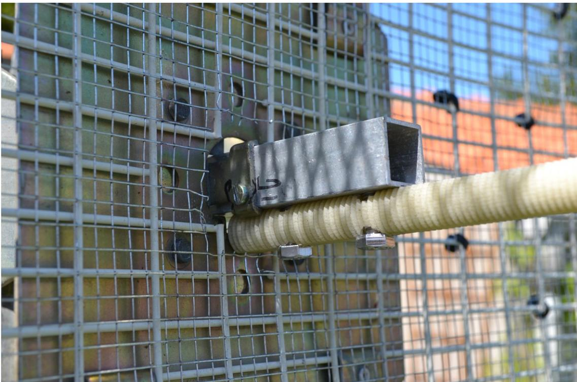
Le réflecteur grillagé d'origine n'est pas du tout adapté à la bande 13cm, il a donc fallu ajouter par-dessus un grillage de mailles plus étroites, la règle étant que la diagonale d'une maille doit être au maximum de 1/10 de la longueur d'onde utilisée.
